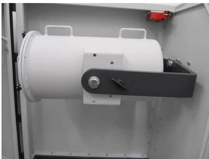
Fig. 15: Modulo a barre da 43,4 litri
